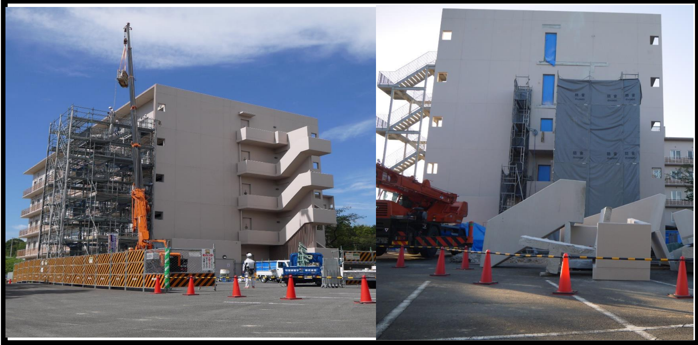
外来棟増設工事 第1段 非常階段の撤去 借り架け替え
